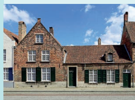
Het nieuwe Tejohuis, momenteel in renovatie
